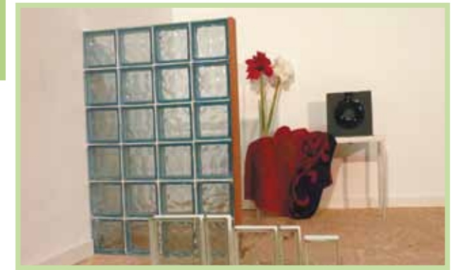
Montage simple et rapide de briques de verre avec joints de carrelage ou silicone
